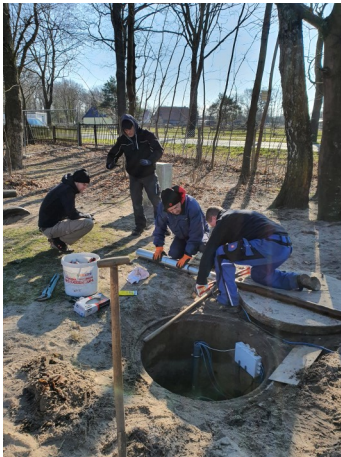
Großes Werkzeug und viel Muskelkraft sind beim Einbau der Pumpe von Nöten.
