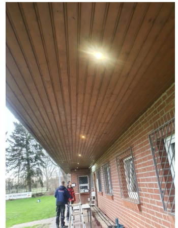
Neue Einbaustrahler beleuchten jetzt die Zuschauerterasse.
